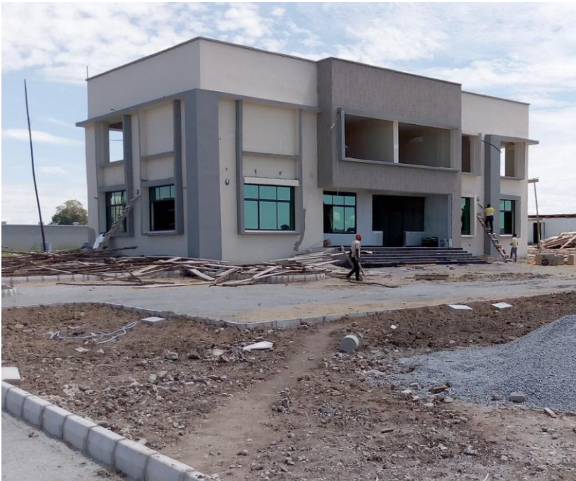
Picha Na. 7: Maendeleo ya Ujenzi wa Kituo cha Umahiri cha Bariadi.
